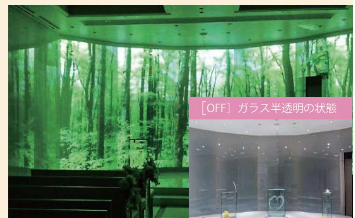
[OFF] 背面から超短焦点プロジェクターで超大型映像出力可能。
